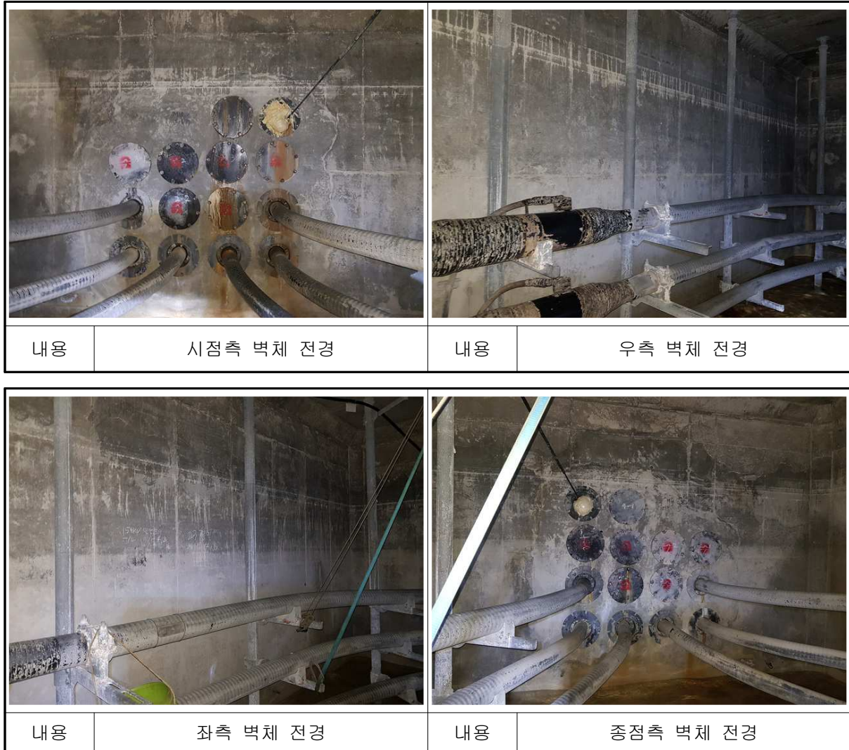
【사진 8.9】 일산~호수#18 전경
