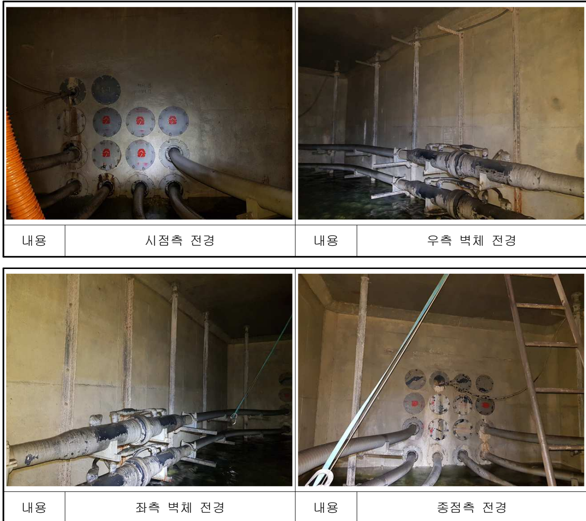
【사진 8.1】 일산~호수 #16 전경
