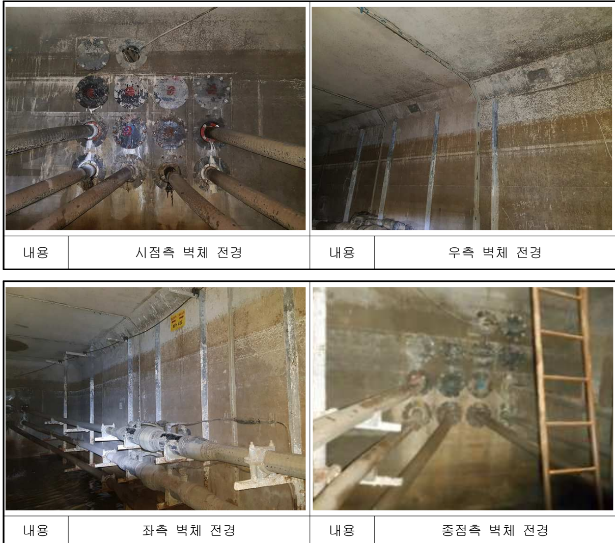
【사진 8.41】 일산~호수#26 전경
