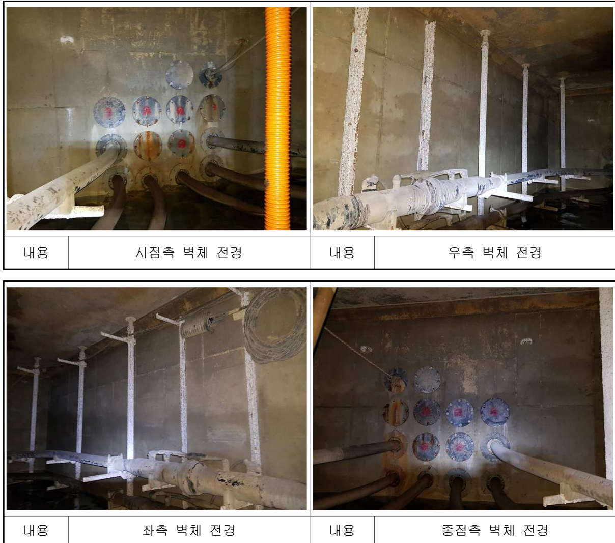
【사진 8.17】 일산~호수#20 전경
