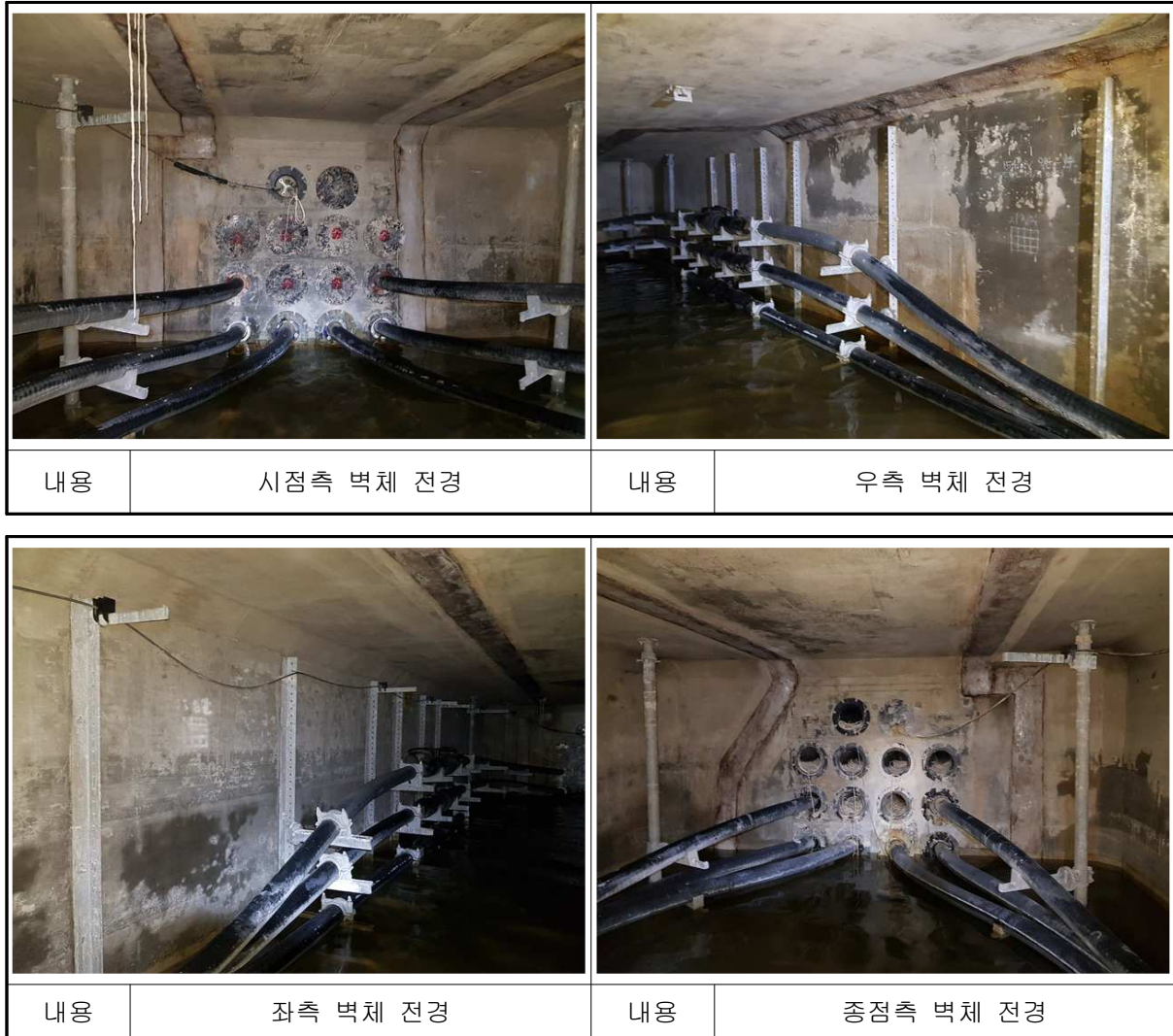
【사진 8.29】 일산~ 호수#23 전경
